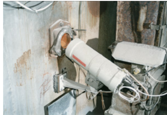
Obr. č. 3 Uchycení CCD kamery na stěně kotle
